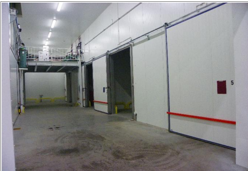
Intérieur du bâtiment.
